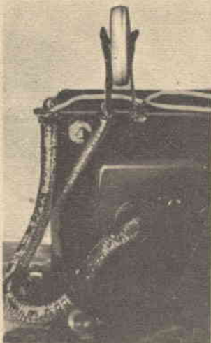
(Sopra) Vista laterale dell'interruttore da lampeggiatore montato sul trasformatore per mezzo di due lamine di ottone.
